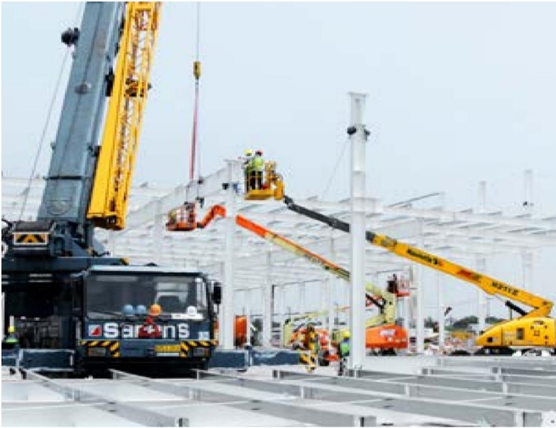
Xe nâng an toàn trong quá trình lắp dựng công trình.
